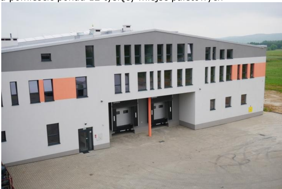
Nowa hala w Gdowie
