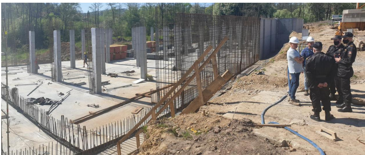
Od stycznia 2021 roku trwają prace budowlane przy budowie Komendy.
