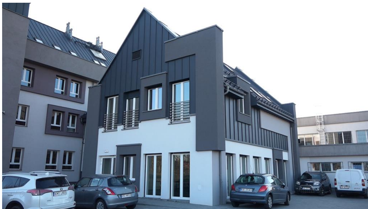
Zespół Szkół Zawodowych w Gdowie po remoncie w 2019 roku
